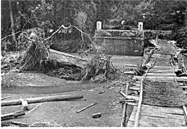
井出町 現浄水場近くの橋
